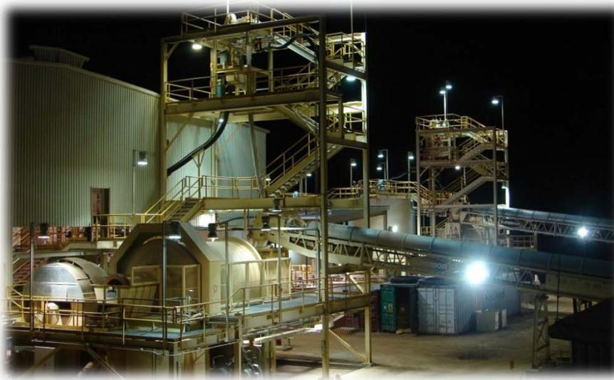
FLOTATIONSKREISLAUF; durchschn. 773 t/Tag 2012. Expansion auf 1.500 t/t derzeit im Gange tonnes/day
